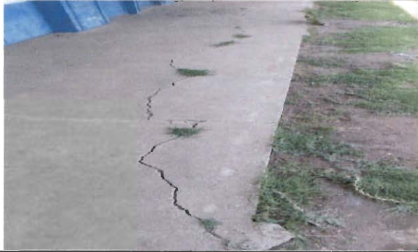
Foto1: Reparacion de piso de torta de Concreto
