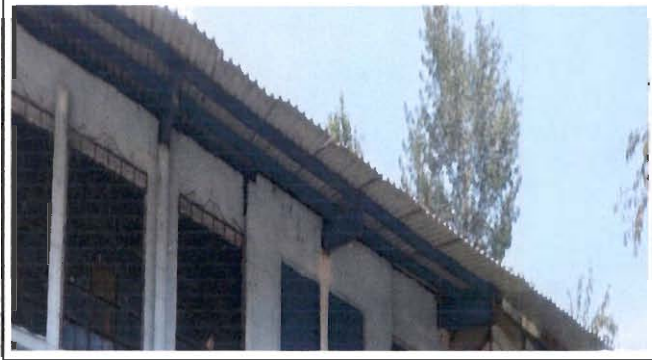
Foto 2: Sustitucion de canal de PVC, reparacion de bajada de agua pluvial tubo PVC 3"y sustitucion de Pescantes de metal para canal.
