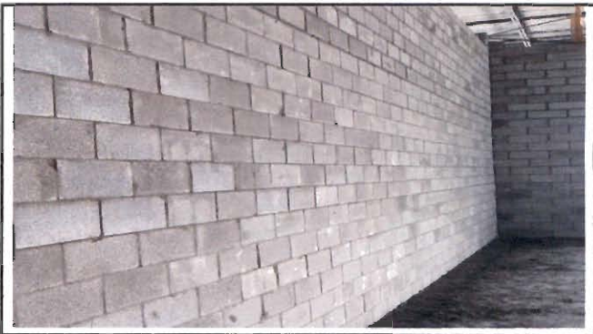
Foto 4: Reparación de muros de contencion.
