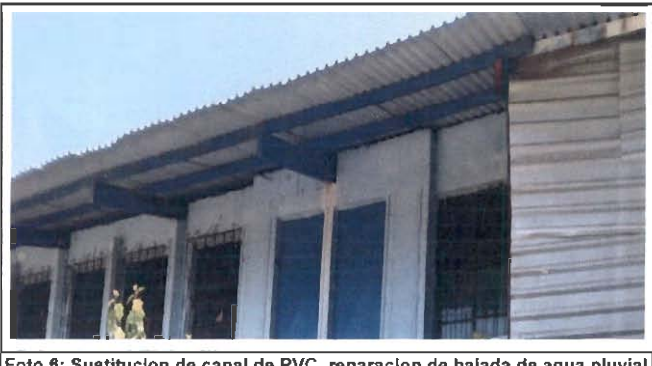
Foto 6: Sustitucion de canal de PVC, reparacion de bajada de agua pluvial tubo PVC 3"y sustitucion de Pescantes de metal para canal.
